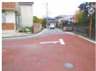
町道 235 号線の道幅が狭い区間
