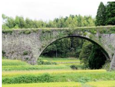
通潤橋（国指定重要文化財） 1854年に完成した水路橋
